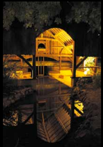
SAINT-MARTIN-DE-BOSSENAY. Le lavoir, sur le ru Saint-Pierre.
